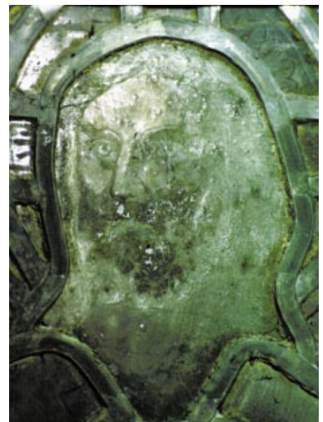
Bild 6: Glasfenster der Kirche St. Michael und Joh. Baptist, Brakel/NRW; die durch Mikroorganismen induzierten Beläge werden im Auflicht deutlich sichtbar
