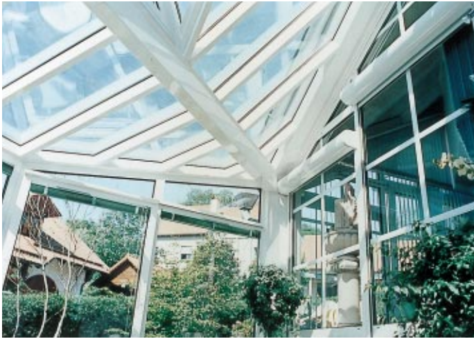
Im Kehlsparnenbereich wurden die Dachprofile geschlitzt, so entstanden die gewünschten verschiedenen Dachneigungen Bilder: Reynolds
