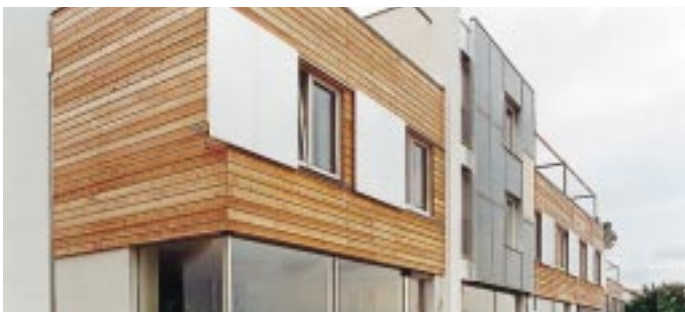
1000 Fenster hatte Eurotec in die Objekte der Passivhaus-Siedlung „Im Sonnengfeld“ zu liefern: Lochfenster, überwiegend türhohe Elemente sowie Hauseingangstüren der „Serie 0,5“
