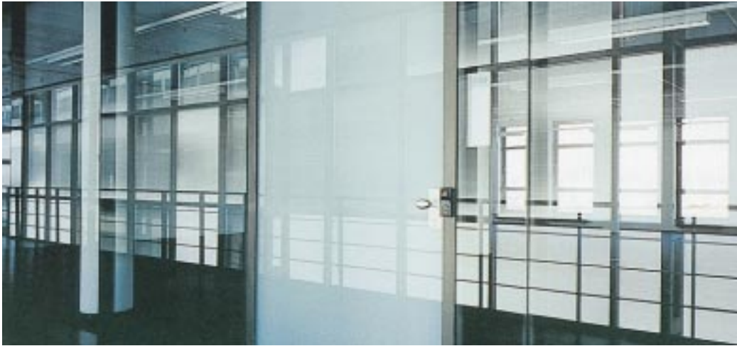
Die Architekten Fink + Jocher, München, gewannen den Benedictus Award 2000 von DuPont im Bereich kommerzielle Gebäude mit dem Entwicklungszentrum des Automobilherstellers Audi AG, Ingolstadt. Das Verbund-Sicherheitsglas für dieses Projekt lieferte die Flachglas AG, Gelsenkirchen. Die flexiblen, kostengünstigen und funktionalen Wände aus Verbund-Sicherheitsglas im Innern des Gebäudes lassen das Tageslicht optimal ein und ermöglichen unterschiedliche Transparenzgrade für individuell ausgeleuchtete Büros.
