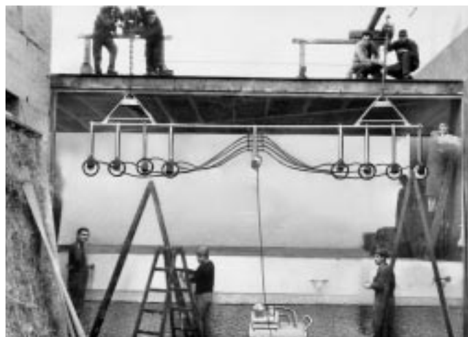
Frühe Vakuum- hebergeräte beim Einsetzen einer Schaufenster- scheibe Anfang der 60er Jahre
