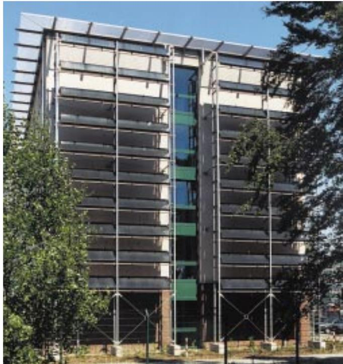
*Gebäude mit 68 m<sup>2</sup> Flachkollektoren in Fassadenmontage auf separatem Gerüst*
