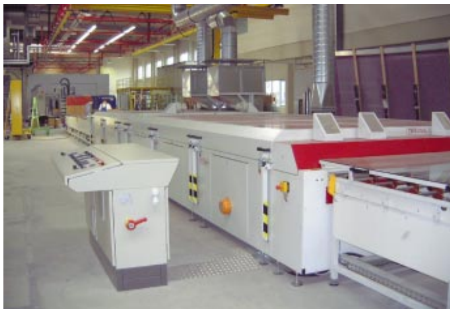
Durchlauftrockner sorgen in der 48 m langen Produktionslinie, für rasche Arbeitsabläufe
