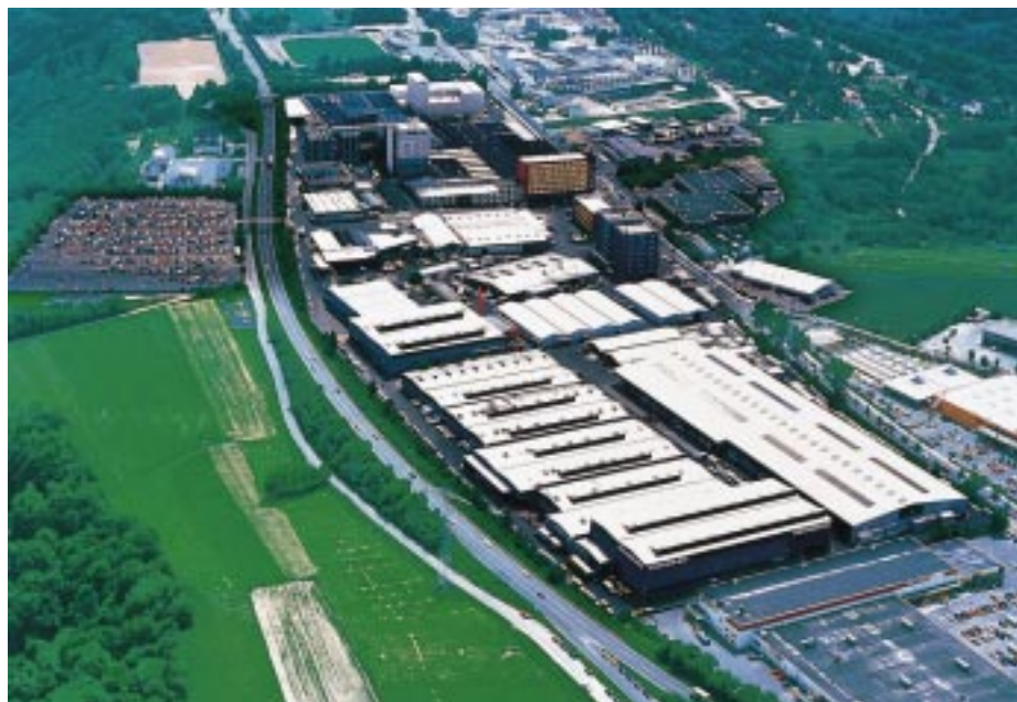
Das Hauptwerk von Kömmerling in Pirmasens mit 140 Extrusionsanlagen und einer Jahresproduktion von über 100 000 t PVC-Profilen
