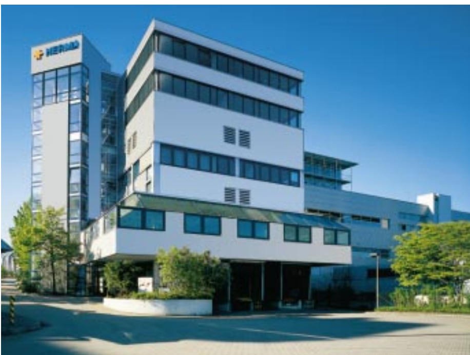
Gut geplante Bauerweiterung mit RWA und natürlicher Lüftung
