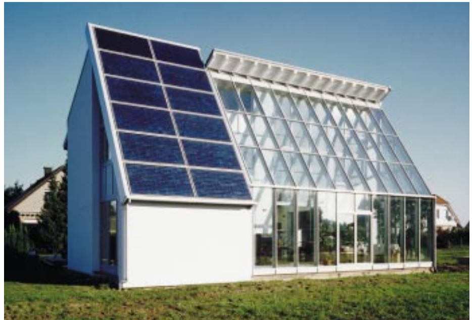
Einheitliches Erscheinungsbild: Photovoltaik (zehn Module) und Solarthermie (zwei Kollektoren, oberste Reihe) sind hier im gleichen „Look“ integriert Bild: Schüco
