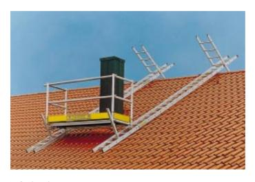
Arbeitsseite werden Aufnahmekonsolen für die Plattform befestigt. Die Konsolen sind verstellbar. Sie können also der Dachneigung angepaßt werden.
