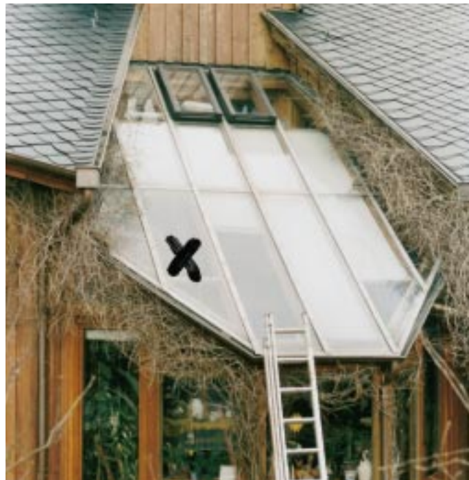
Bild 1: Ribbildung in der markierten Scheibe
