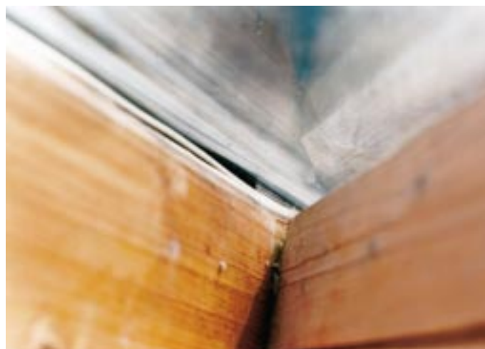
Bild 4: 4 bis 5 mm dickes Holzstück unmittelbar unter der Glasscheibe
