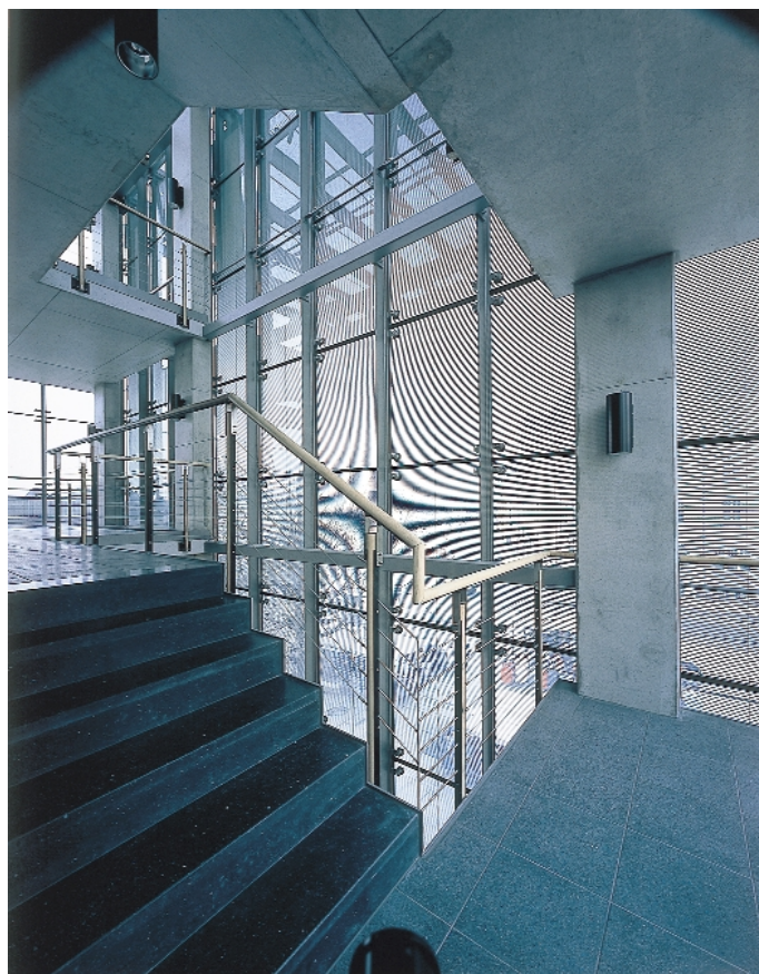
Das Treppenhaus des Eisenbahnbundesamtes ist mit punktgehaltenem „Okasolar“ Isolierglas ausgestattet
