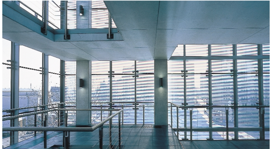
Das Lichtlenksystem in der Fassade des Eisenbahnbundesamtes in Halle erlaubt einen blendfreien Blick nach draußen
