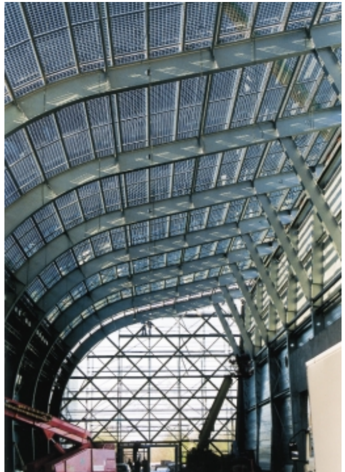
Die vor kurzem fertiggestellte Galeria der Messe Essen wurde mit einem 2000 m 2 großen Solardach ausgestattet. Die Photovoltaikelemente von Flabeg Solar International, Köln, für die Dach- und Fassadenpaneele erzeugen nicht nur Energie (pro Jahr 150 000 kW/h), sondern dienen gleichzeitig auch der Verschattung
