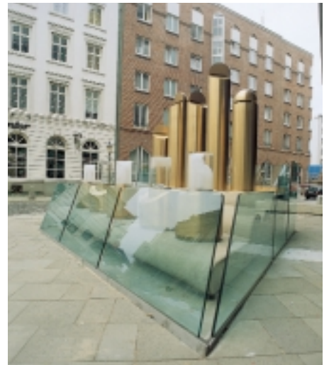
An Brüstungsverglasungen im Außenraum werden höchste Anforderungen gestellt; bis jetzt sind hierfür noch Einzelzulassungen notwendig Bild: Vera Klose
