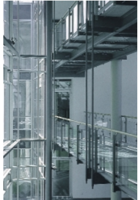
Die geringsten Anforderungen werden an die Kategorie C gestellt; dabei werden die Holmlasten nicht durch Glas aufgenommen, hier durch eine Stahlkonstruktion Bild: Rudolf Mais
