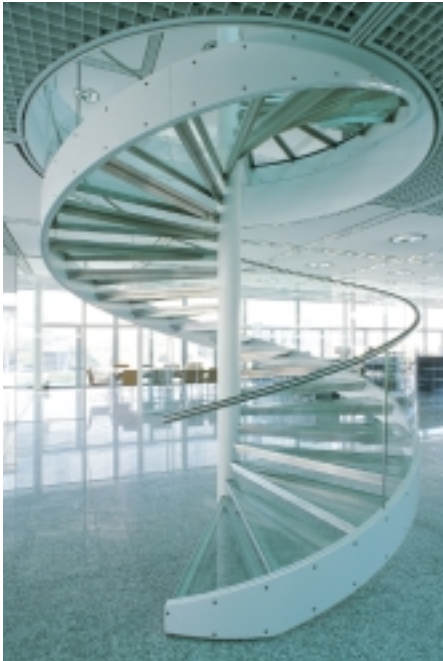
Bei Treppen der Kategorie B muß der Handlauf bei Ausfall einer Scheibe in der Lage sein, die Holmlast auf die Nachbartscheiben zu übertragen Bild: Sanco
