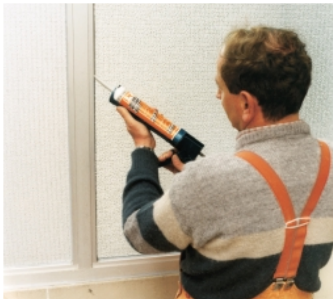
Bild 3: Fachgerechtes Verarbeiten von fungizid ausgerüsteten, leicht spritz- und glättbaren, elastischem Silikon-Dichtstoff „PCI-Silcoferm VE“ beim Schließen von Bewegungsfugen zwischen Aluminiumrahmen und Drahtglas an einer Duschkabine
