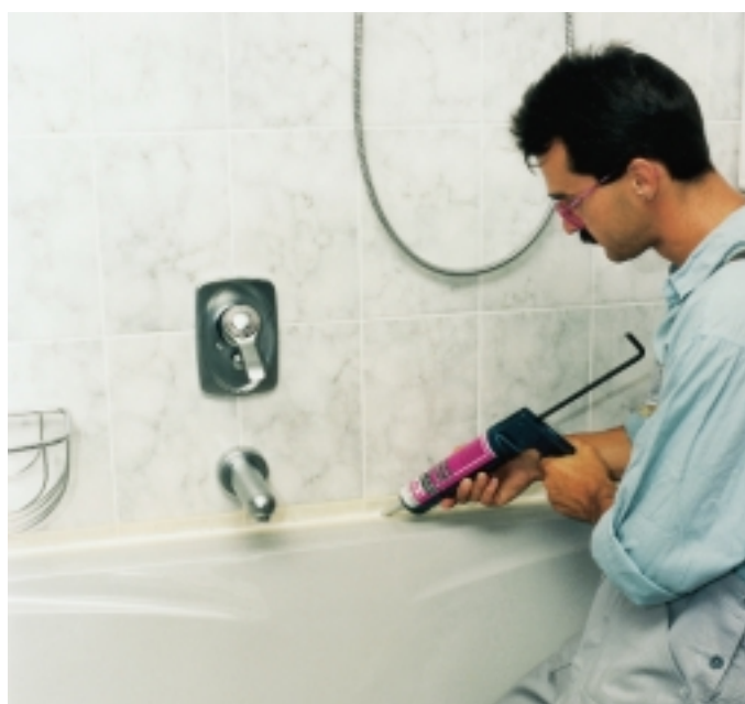
Bild 5: Elastisches Schließen der Anschlußfuge zwischen Emaille-Badewanne und keramischem Fliesenbelag mit Silikon-Dichtstoff „PCI-Siligum E“
