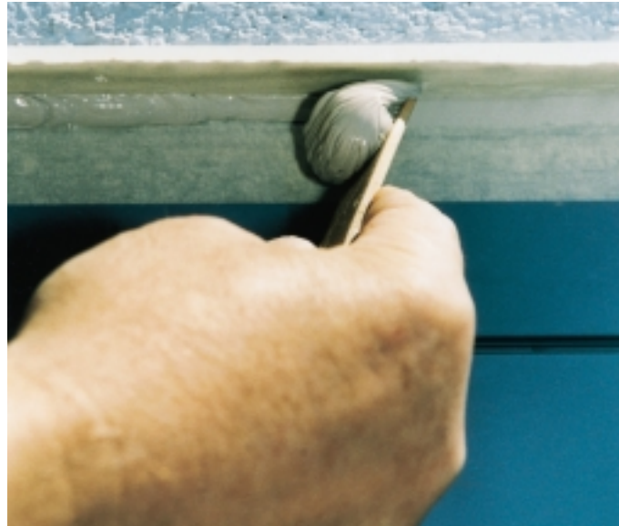
Bild 9: Glattes Abziehen frisch ausgespritzten Dichtstoffs mit entsprechendem Hilfswerkzeug Bilder: PCI Augsburg
