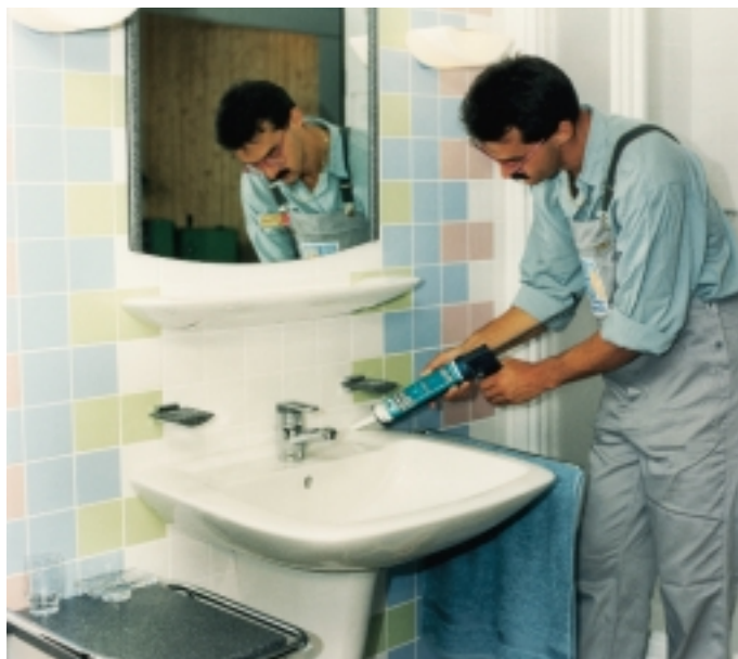
Bild 6: Abdichten des Anschlusses zwischen Wandbekleidung aus keramischen Fliesen und Waschbecken mit selbsthaftendem, spritzhemmend ausgerüstetem, gegen handelsübliche Haushaltsreiniger und Desinfektionsmittel beständigem, elastischem Silikon-Dichtstoff "PCI-Silcoferm S"
