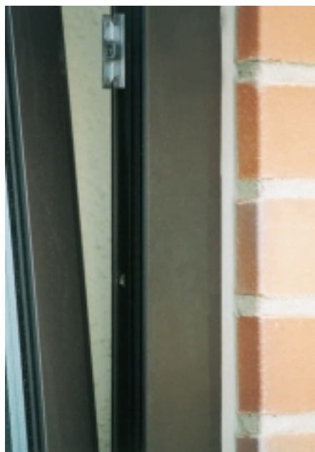
Optisch ansprechend und technisch korrekt: ausgeführte Fuge am Fenster
