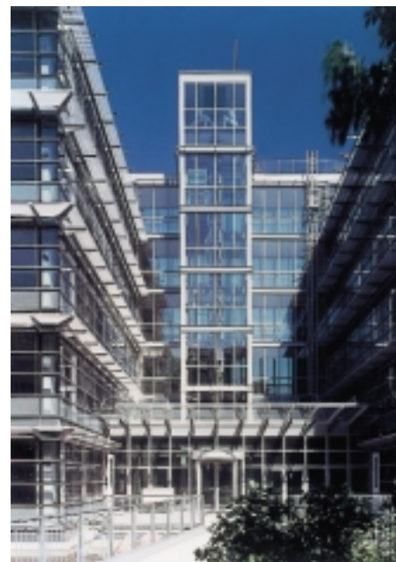
Bild 2: Einer der Eingangsbereiche: Zum Schutz vor vertikalem und horizontalem Feuerüberschlag wurden F 90 Verglasungen gewählt
