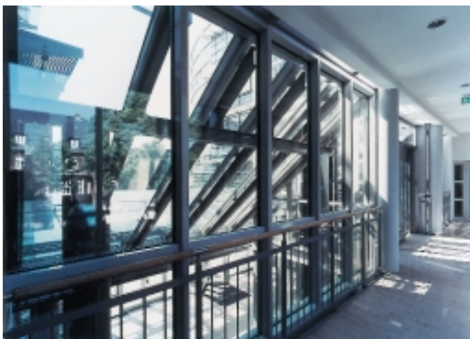
Bild 5: Einer der brandschutzverglasten „Laufstege“ zwischen den Gebäudeeinheiten
