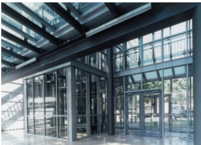
Bild 4: Vorgesetzte Glashalle – die innere Trennwand ist über die gesamte Höhe und Breite in F 90 ausgeführt; die Behörden verzichteten daher auf weitere Brandschutzanforderungen an die Dachverglasung
