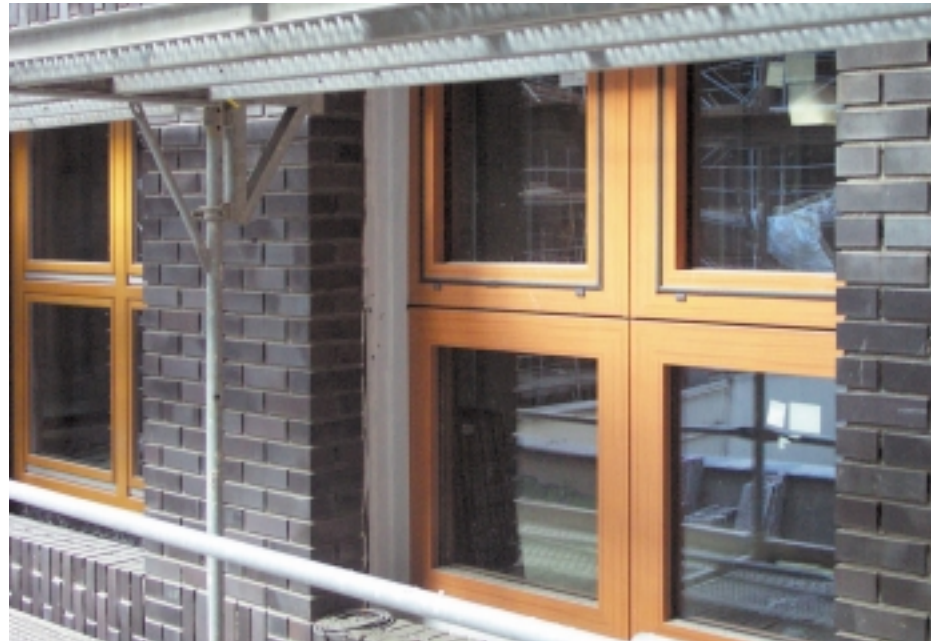
Das Brandschutz-Fenster rechts im Bild erfüllt nicht nur die G-90-Anforderungen, sondern ist auch in Farbe und Struktur an die umgebenden Holzfenster (links) angepaßt
