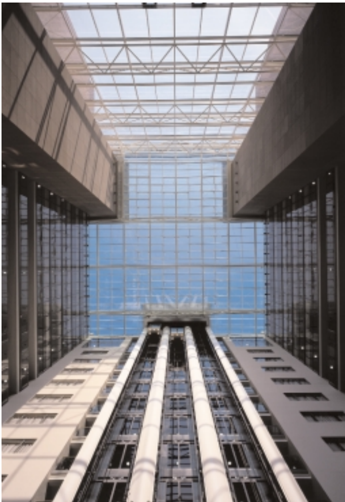
Das Glasdach des Atriums überspannt stützenfrei 36 × 38 m. Für die Verglasung kam außen VSG, im Innenbereich ESG zum Einsatz
