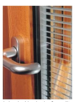
Im Innenbereich und nach außen gewährleistet das Lamellensystem neben der Lichtlenkung auch einen guten Sichtschutz
