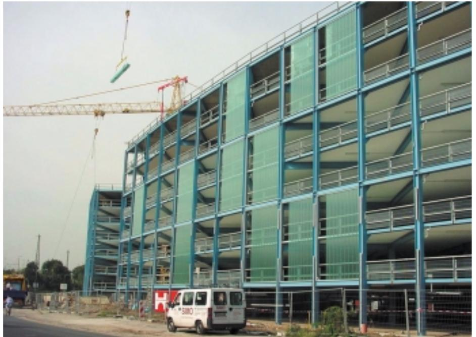
Die Hochgarage für die Frankfurter Messe wurde mit „Profilit“ verkleidet – dazu war ein spezielles Vakuumhebergerät notwendig
