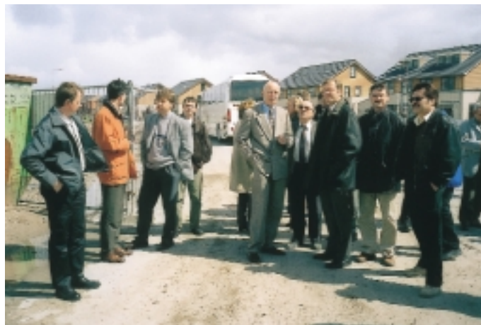
Die Mitglieder der Erfa-Gruppe begutachten den Fenstereinbau auf einer niederländischen Baustelle
