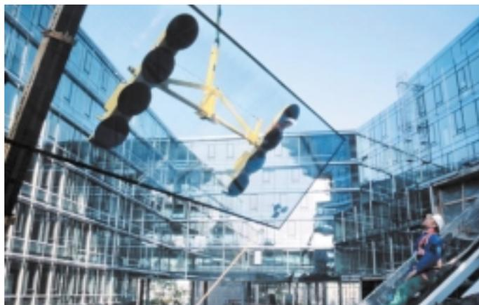
*Die Außenfassade wurde mit über 32 000 m<sup>2</sup> Isolier- und Sicherheitsglas bestückt*
