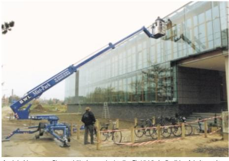
Auch bei beengten Platzverhältnissen erlaubt die "TL 15 h" ein flexibles Arbeiten mit ihrer seitlichen Reichweite von über zehn Metern
