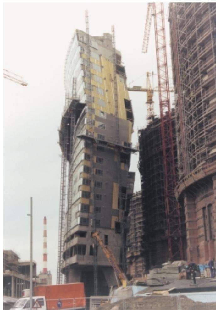
Damit die Arbeitsplattformen möglichst nahe an die Fassade heranreichten, wurden die Plattformen mittels verschiebbarer Platten vergrößert. An der Stirnseite ist eine Doppelmastbühne ohne Erweiterungsplatte zu sehen
