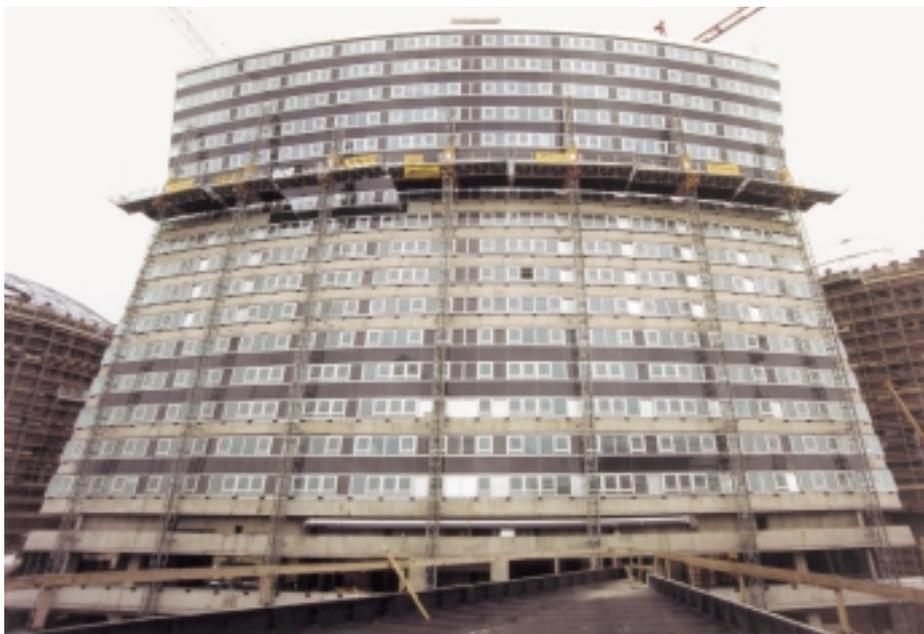
Mit Hilfe variabler Arbeitsbühnen von HEK wurde der Erweiterungsbau eines alten Wiener Gasbehälters, in horizontal getrennten Abschnitten, Stockwerk für Stockwerk errichtet. Die Plattformen besaßen eine Länge von zusammen 70 m
