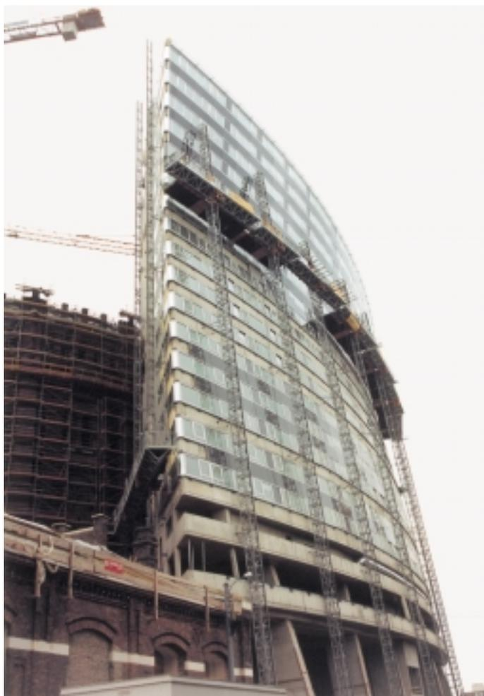
Normalerweise erfordern große Fassadenlängen den Einsatz von Doppelmastbühnen. Die Verwendung von Einzelmastanlagen (ein Mast pro Arbeitsbühne) erleichterte es aber dem Radius des Bauwerks zu folgen
