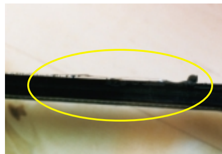
Bild 7: Die Folie zwischen den beiden Scheiben der VSG-Verglasung steht bis zu 2 mm an den Kanten vor, das entspricht nicht der DIN EN ISO 12 543-5 „Verbundglas und Verbund-Sicherheitsglas“, Teil 5
