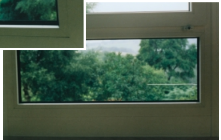
Bild 1: Je nach Blickwinkel kann der Betrachter nicht immer einen Fehler im Glas, hier ein Riß, wahrnehmen. Das Detail zeigt die selbe Stelle wie im großen Bild, diesmal mit dem gesamten Rißverlauf
