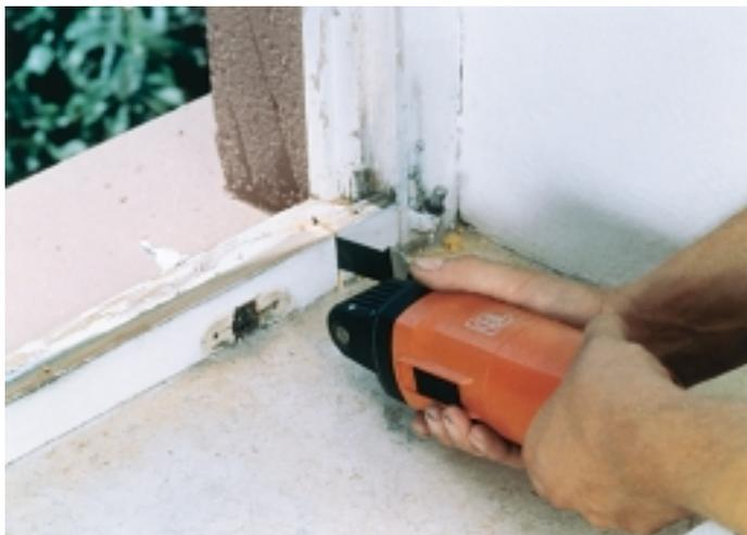
Mit dem „SuperCut Profi-Set“ für Glaser und Fenstersanierer können beispielsweise Altfenster ohne Beschädigung der Tapete bzw. der Fliesen entfernt werden
