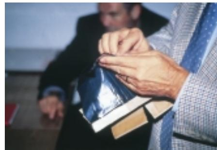
*Gewußt, wie: Mit dem richtigen Schnitt . . . läßt sich die selbstklebende Folie zur Ecke falten . . . und einfach verarbeiten*
