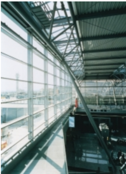
Wärmeschutzgläser für die Fassade zum Flugfeld: Wo zusätzliche Sicherheit gefordert ist, wurde Pilkington „Optitherm SN“ mit Verbundsicherheitsglas kombiniert Bilder: Pilkington
