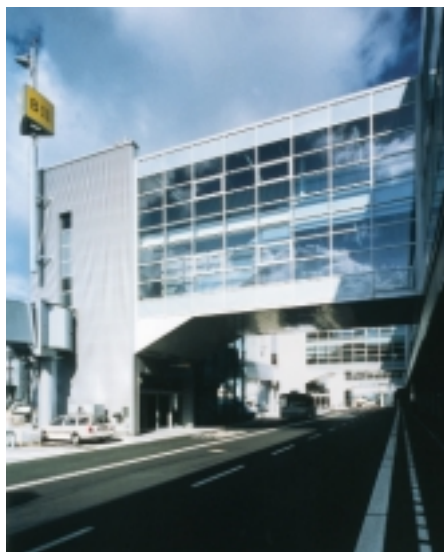
Im 5 m breiten Anschlußbereich an die Fassade zum Flugfeld sind die Fluggastbrücken mit Brandschutzgläsern ausgestattet
