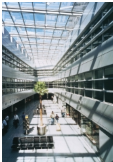
Die Fassadenverglasungen der Atrien erfüllen die Anforderungen der Feuerwiderstandsklasse G 30
