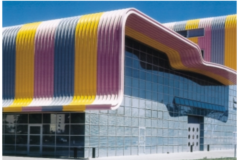
Bild 1: Die bedruckte Verglasung der Seitenfassaden kombiniert Sicht- und Schallschutz- mit Sicherheitsfunktionen und wurde in „Infrastop Titan 63/37“ ausgeführt
