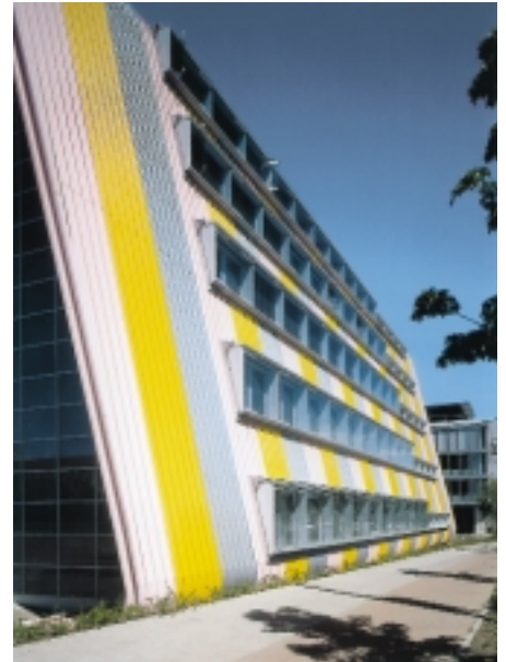
Bild 4: Vertikales und horizontales Wechselspiel von lackiertem Stahlblech und Fensterbändern, die als Kastenfenster ausgeführt wurden Bilder: Flachglas
