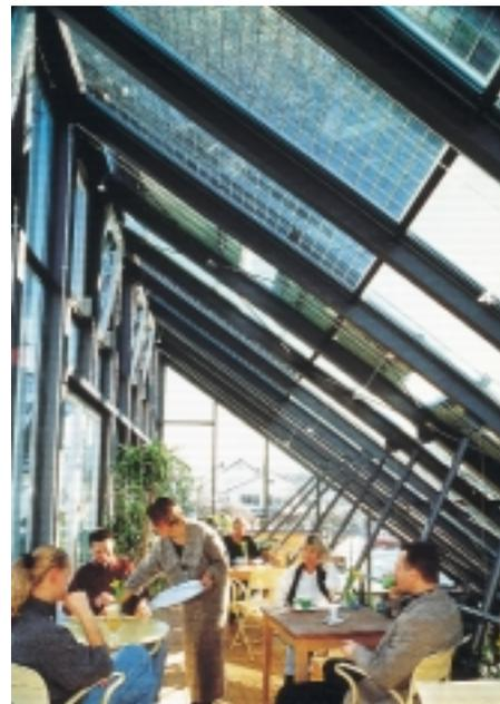
*Die transparenten Solarzellen produzieren nicht nur Strom, sie können auch als Sonnenschutz eingesetzt werden*
