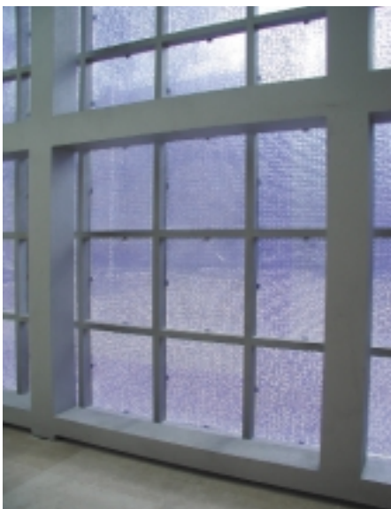
Die Fassade im Detail
