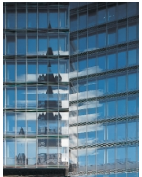
Keine Spiegelung der gegenüberliegenden Kirche, sondern ein Ausschnitt aus dem Foto, das an der Glasfassade des Kölnturms zu erkennen ist – die Glasfassade besteht aus siebbedruckten Unikatscheiben Bilder: BGT Bischoff
