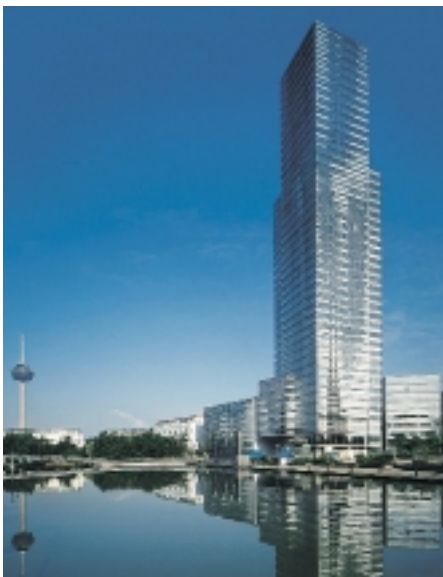
Motive der Rheinuferpromenade schmücken das neue Hochhaus im Kölner Medienpark
