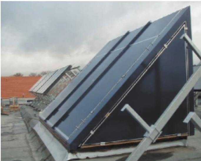
*In den Sheddachkonstruktionen sind über 250 m<sup>2</sup> Sonnenkollektoren eingebaut*
