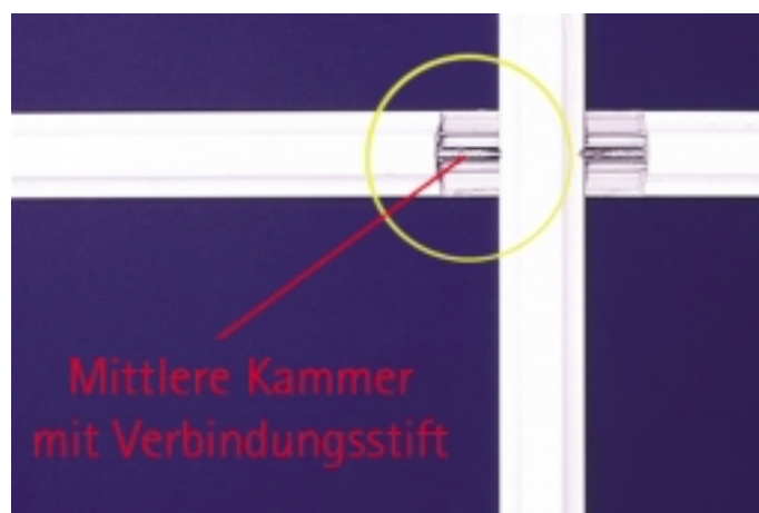
Bild 3: Die mittlere Kammer der Sprosse nimmt einen Verbindungsstift (ø 4 × 120 mm) auf. Dieser trägt und verbindet die senkrechte Sprosse im konfektio-
