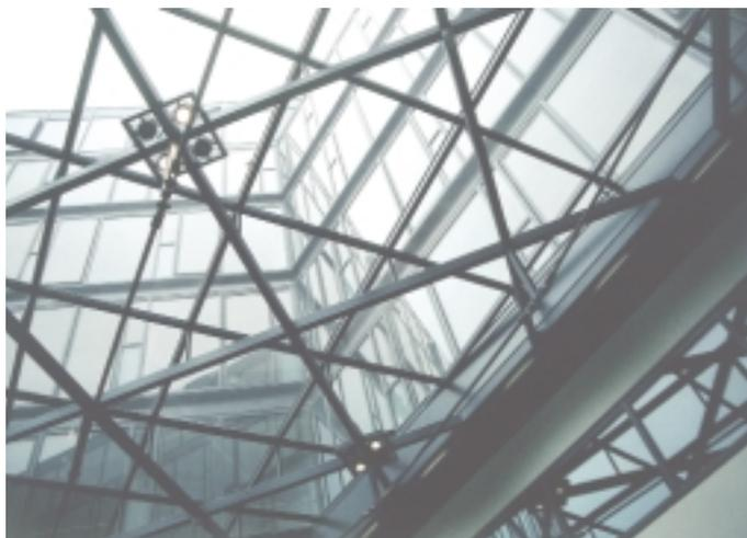
Das siebbedruckte Glas im Dachbereich reduziert deutlich den Energiedurchlaßgrad (g-Wert)
