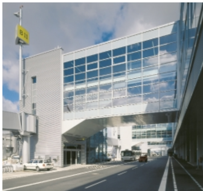
Im Inneneckbereich von Fassaden sind Brandschutzgläser von normalen Funktionsverglasungen nicht zu unterscheiden Bilder: Pilkington
