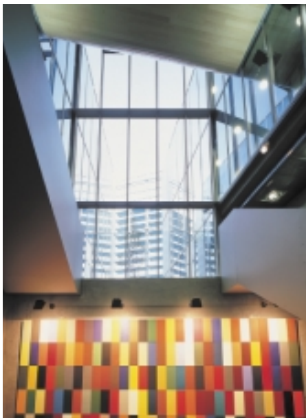
Auch bei Atriumfassaden bieten Brandschutzgläser eine Kombination aus Offenheit und Sicherheit mit vorschriftsgemäßem Brandschutz
