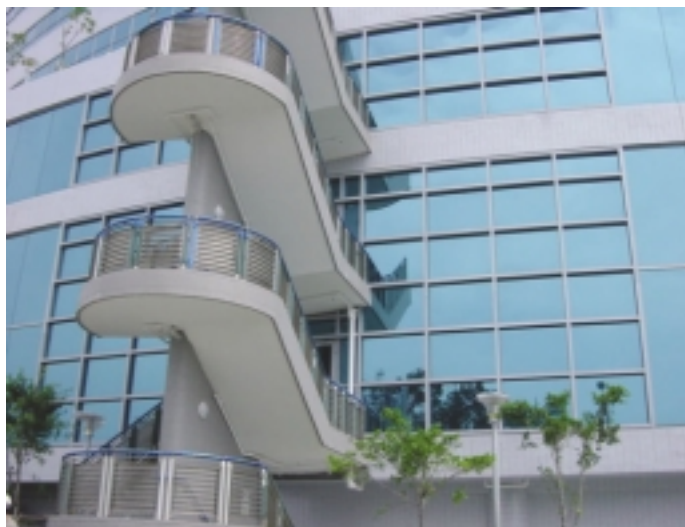
Bild 2: Vorgelagertes Fluchttreppenhaus geschützt durch einen großflächigen Fassadenbereich mit „Paraflam“-Isolierglas mit integrierter metallbeschichteter blauer Sonnenschutzscheibe, Glaslieferant Steindl Glas, Itter(Tirol)
