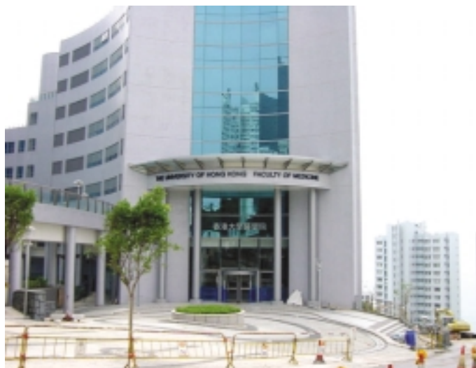
Bild 1: Ansicht auf den Haupteingang der University of Hong Kong, Faculty of Medicine
