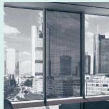
*Solarthermische Energiegewinnung ermöglicht die Schüco „E<sup>2</sup>“- Fassade über großflächig in die Fassade integrierte Elemente mit neuen, transluzenten Flachkollektoren*
