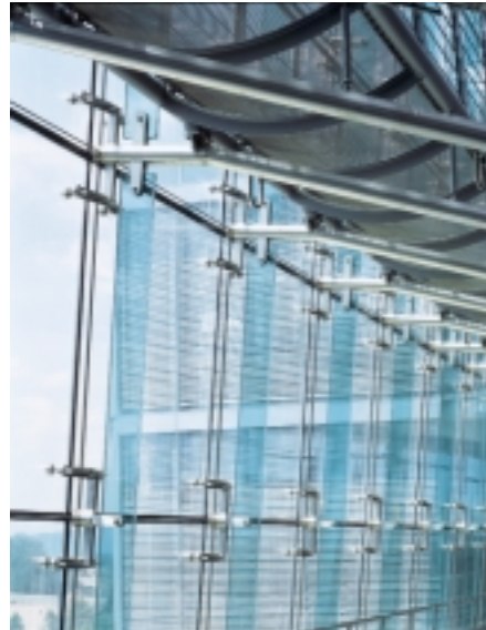
Die nicht alltägliche Fassaden-Konstruktion des Festo Technologie-Centers wird vorgestellt
