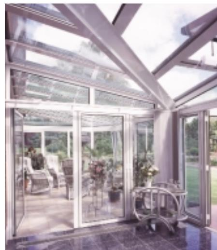
TS Aluminium bietet neben Spezialprofilen für Wintergärten auch vorkonfektionierte Dächer an. Bei Vorfertigung werden die Profile dann im Großbefehrer Stammhaus zugeschnitten und aufgebaut und von dort zur Montage auf die Baustelle geschickt
