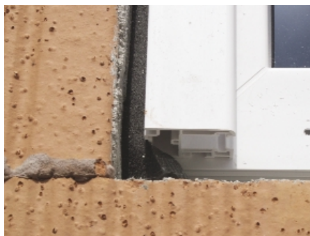
Bild 3: Bei einer solchen Rolladenschiene mit ca. 20 mm Hohlkammer, bewirkt diese Kammer eine der Überdeckung fast vergleichbare Dämmung
