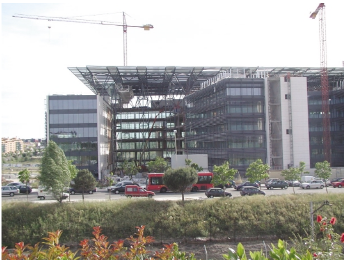
Für die imposante Ansicht wurden 24 483 m 2 Glas und Aluminium verarbeitet
