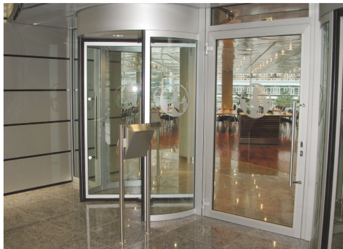
Bild 2: Gebogene Brandschutzverglasungen können mit „Contraflam N2 Contour“ realisiert werden
