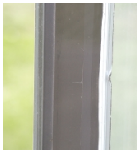
Bild 6: Derart breite Dichtstoff-Bereiche – hier bei einer Ganzglas-Ecke – sind kritisch
