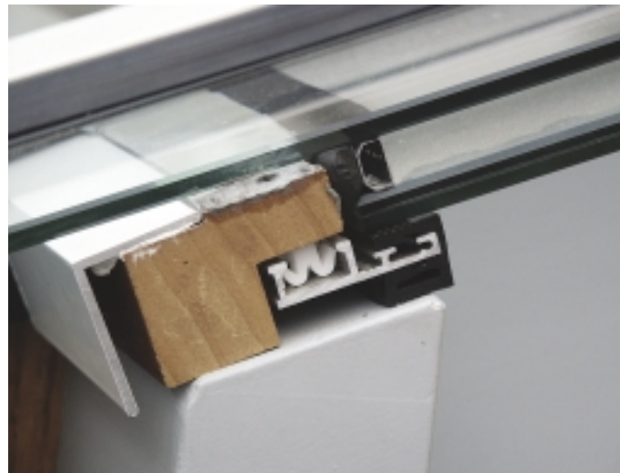
Bild 10: Alle Materialien, die mit dem MIG-Randverbund in Kontakt kommen, müssen mit diesem verträglich sein
