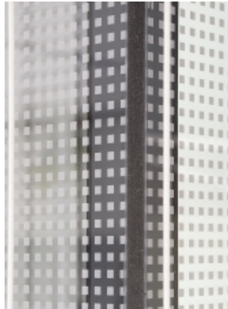
Bild 2: Detail-Ansicht einer mit Dichtstoff abgedichteten Ganzglas-Ecke
