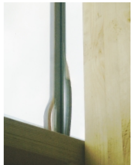
Bild 8: Beim Girlandeneffekt wandert der TPS-Abstandhalter infolge von Material-Unverträglichkeiten ins Glaslichte
