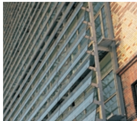
Detailansicht der Fassade mit vorgehängten Glaslamellen Bilder: Jansen
