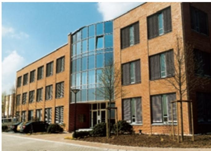
Bei einem Bauvorhaben der System Gewerbeimmobilien GmbH & Co. KG im hessischen Dietzenbach konnten sich die farbigen „Acrylcolor“-Fensterprofile von Gealan gegen eine ursprünglich geplante Leichtmetallfassade durchsetzen
