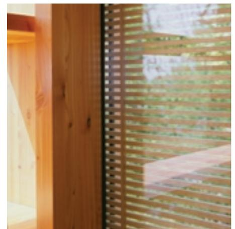
Das „Okawood“-Glaspaneel besteht außen und innen aus ESG, wobei die äußere Scheibe mit einer Low-E-Beschichtung versehen ist, der SZR mit Holzeinlage hat eine Stärke von 18 mm Bilder: Okalux
