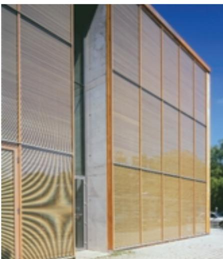
Der Isolierglashersteller Okalux, Marktheidenfeld, entwickelte auf Anregung des Architekturbüros Mahler Günster Fuchs, Stuttgart, für die Fassade eines FH-Gebäudes in Wiesbaden ein Glaspaneel, bei dem im SZR filigrane Holzlamellen eingelegt sind
