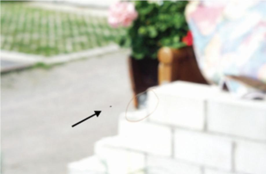
Bild 2: Ansicht eines eingebrannten Metallsplitters auf der Außenseite des Isolierglases
