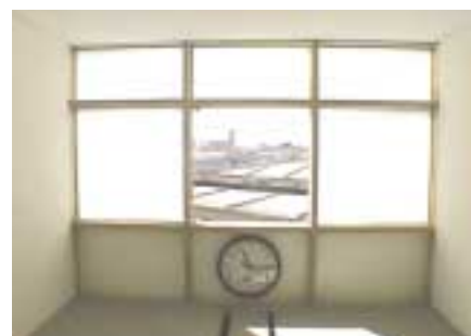
Bild 2: Im geschalteten Zustand, wird das einfallende Sonnenlicht diffus reflektiert
