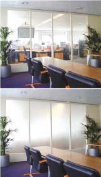
Bild 9: Schaltbare Verglasung ermöglicht Diskretion auf Knopfdruck
